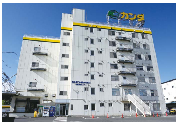
「関東サービスセンター」（JECC サービスセンター）が位置する岩槻物流センター
