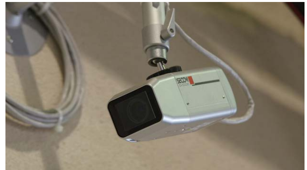
万が一異常が発生した場合、各種センサーが異常を検出し、オンラインで警備会社に通報、早期に対応
